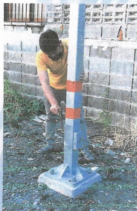
รูประบบเสาไฟแบบรอกสลิงหมุนยกฯ เมื่อปรับระดับลงมาในตำแหน่งที่ทำงานได้
