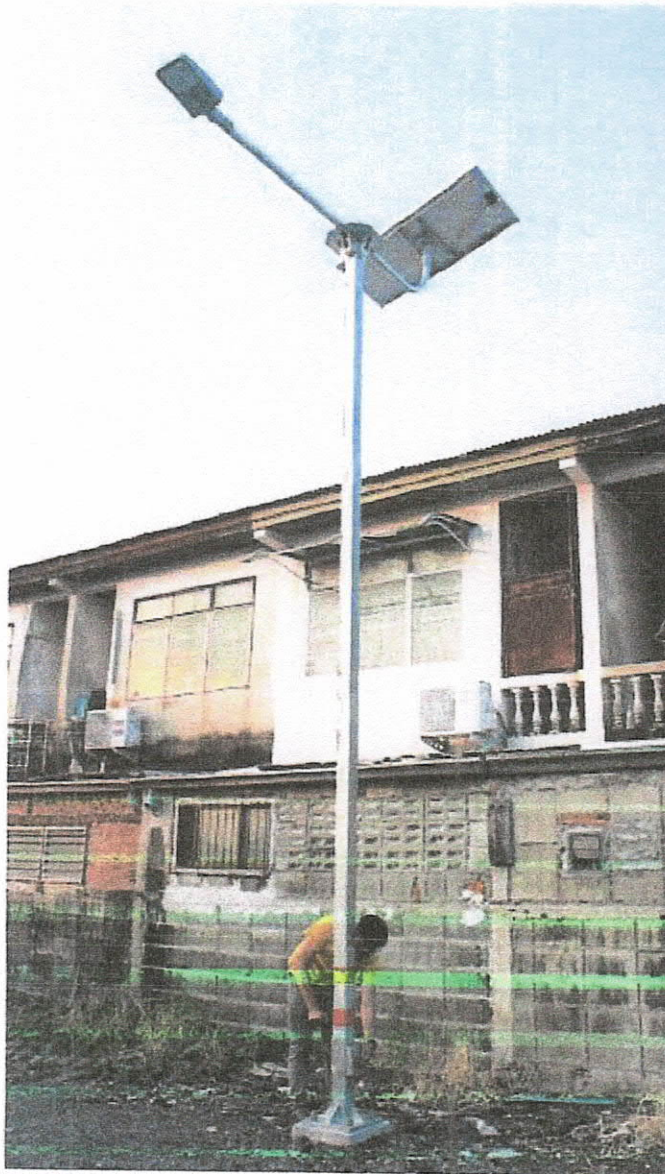
รูปการเลื่อนปรับระดับชุดโคมไฟและแผงเซลล์แสงอาทิตย์
