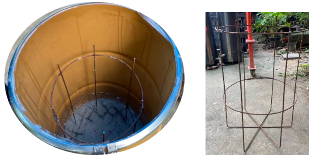
รูปที่ 2 โครงสร้างเหล็กเสริมและการบุด้วยคอนกรีตที่ฐาน
