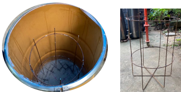
รูปที่ 12 โครงสร้างเหล็กเสริมและการบุด้วยคอนกรีตที่ฐาน
