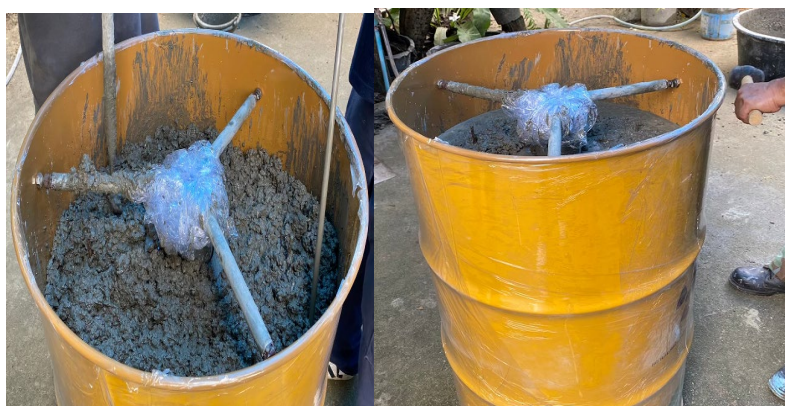
รูปที่ 9 การทำคอนกรีตให้แน่นและไล่อากาศโดยใช้เหล็กกระทุ้งภายในถัง และการใช้ค้อนยาง เคาะภายนอกถัง
